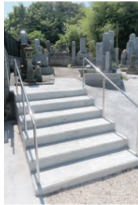
松尾町墓地階段修繕工事により安全かつ快適にお参り出来るようになりました。
